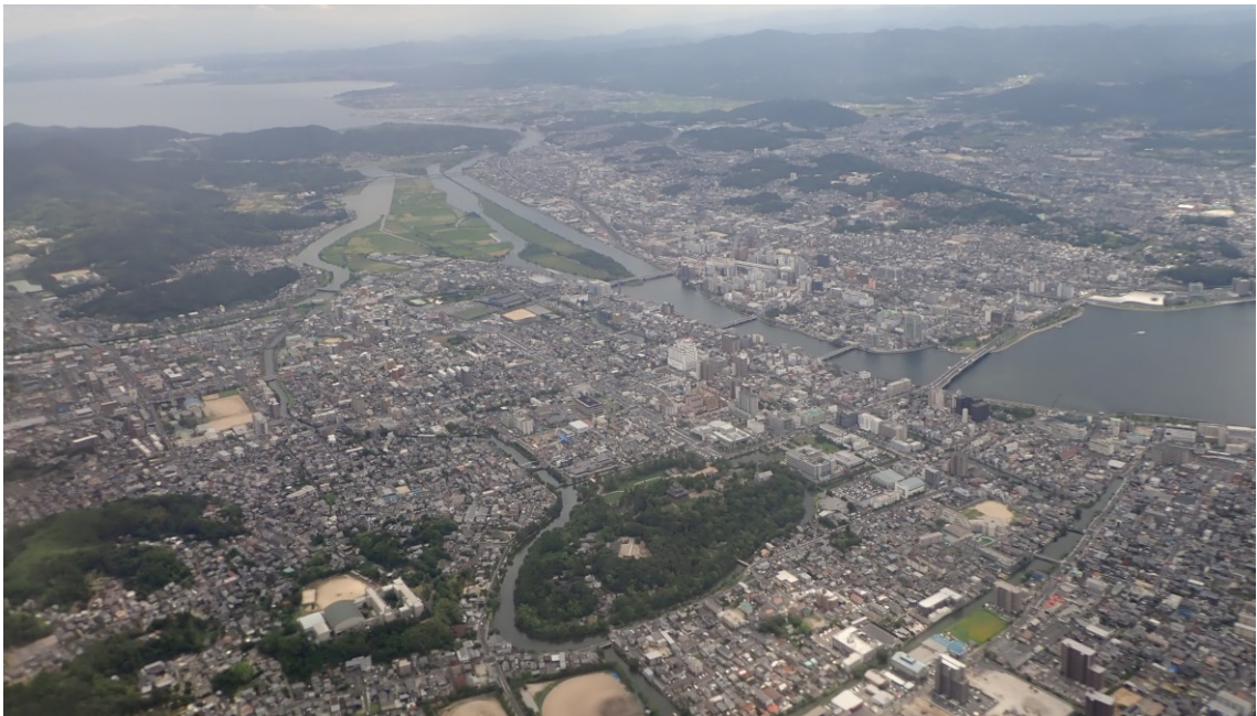
大橋川（島根県松江市）
